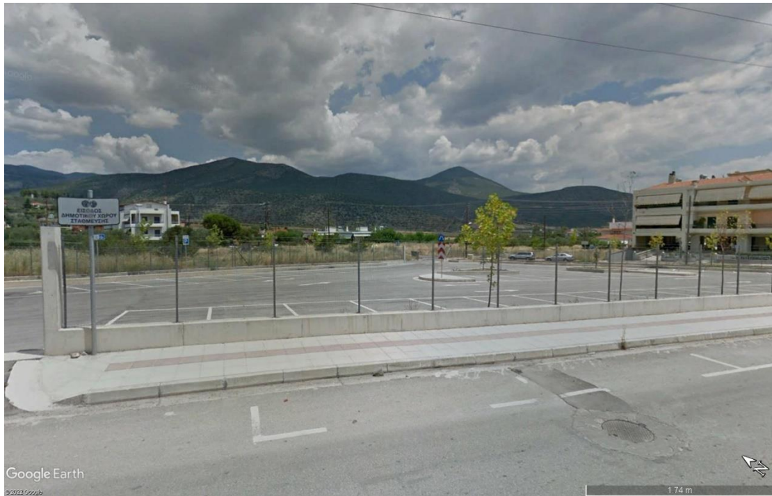
Εικόνα 24: Δημοτικός χώρος στάθμευσης – Αλίτρωτων Πατρίδων (1) & (2) (Υπόβαθρο Google Street)
