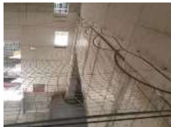
Ειδικές κατασκευές αναμονής από πτώση: δίχτυ προστασίας, στρώματα, κινητοί εξώστες
