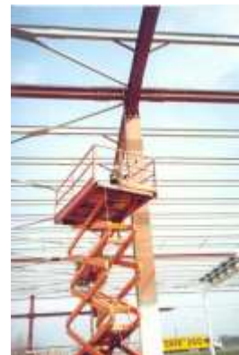
Ειδικές κατασκευές αναμονής από πτώση: δίχτυ προστασίας, στρώματα, κινητοί εξώστες
